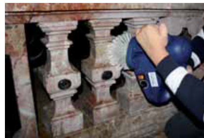
Čiščenje ozkih predelov in sten Cleaning on narrow surfaces
