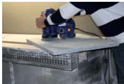
Fino brušenje grobih površin Hard grinding on raw surfaces
